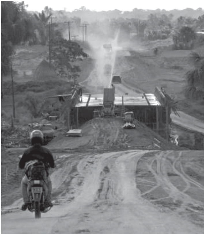
BR-364 em obras (fonte: portal notícias da Amazônia)
