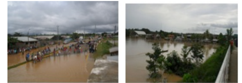
Ilustración 49. Inundación de municipalidad de Iñapari
