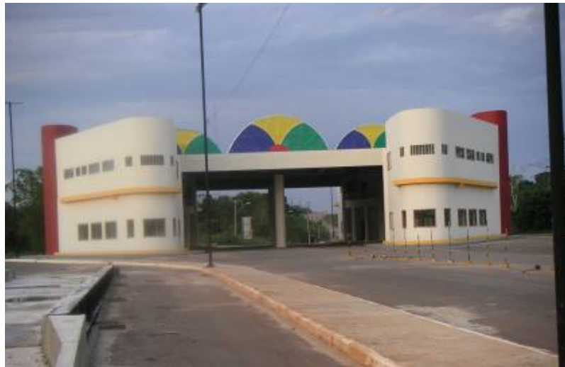
Ilustración 28. Centro de Control del Paso de Frontera Assis-Brasil
