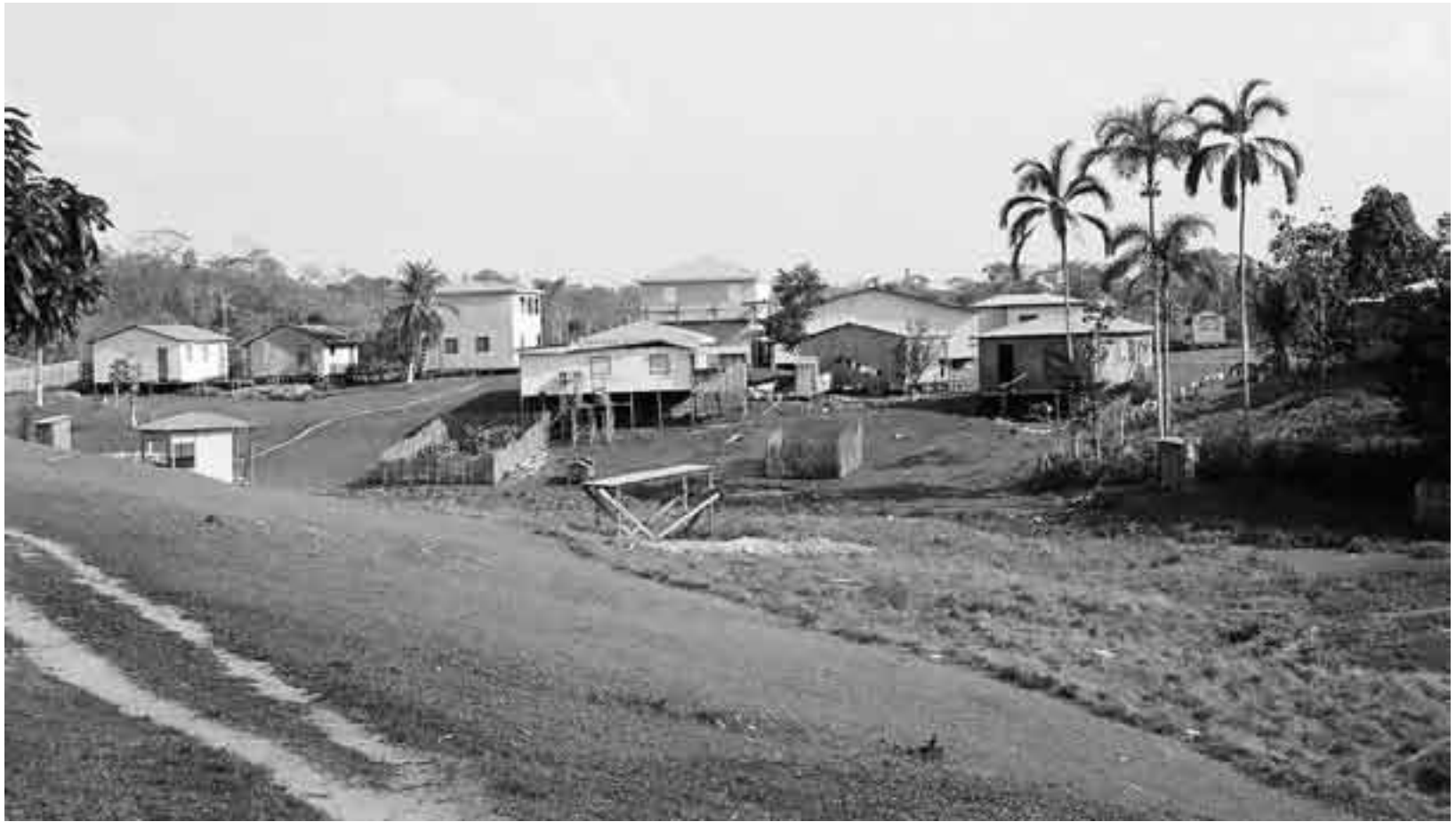
VISTA parcial da vila Restauração. Edificações de dois andares e de alvenaria começam a aparecer
