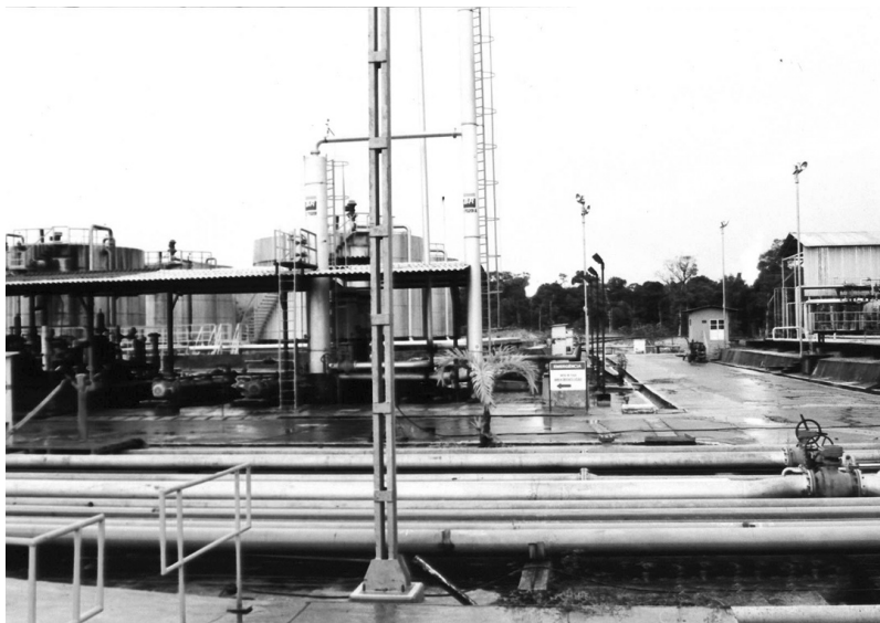
Foto 4: Na área industrial, uma destilaria fabrica óleo diesel, para consumo local; ao fundo uma das casas de compressores e duas tochas de alívio acesas, queimando excesso de gás (Foto: Sevá, 1999)
