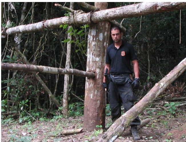
Foto 6 - Estrutura para tracionamento das toras
