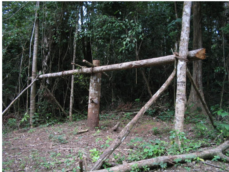
Foto 5 – Estrutura para tracionamento das toras
