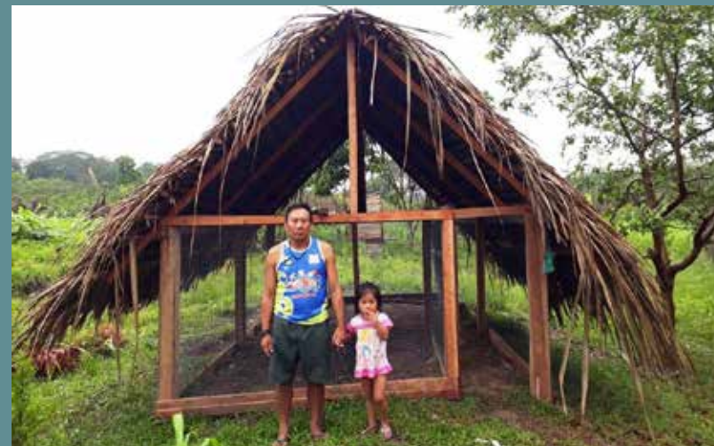
Galinheiro construindo pelo AAFI e comunidade na aldeia 18 Praias. Foto: Raimundo Ferreira, 2020.
