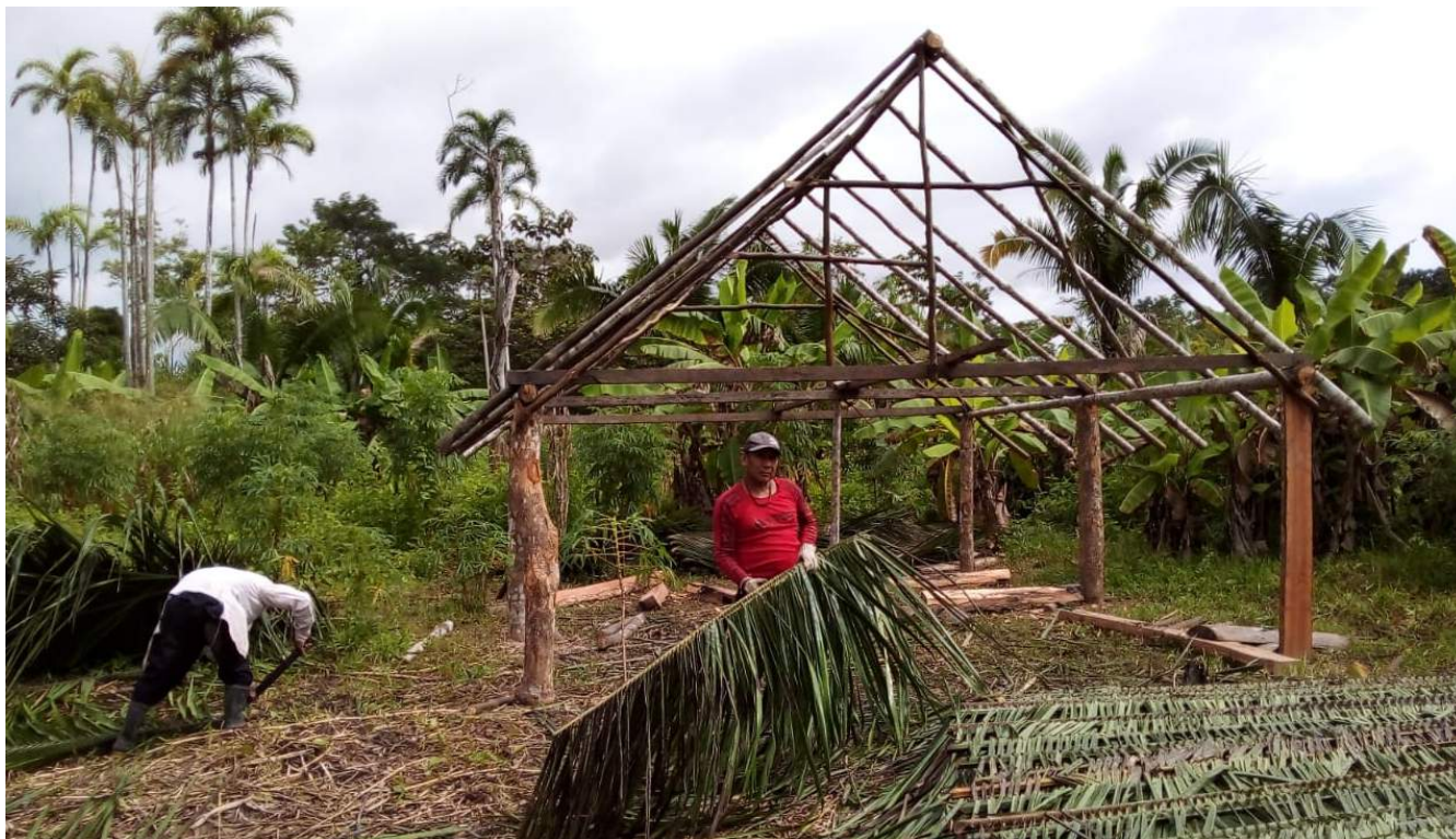
Construção de casa de farinha. Foto: Raimundo Beci
